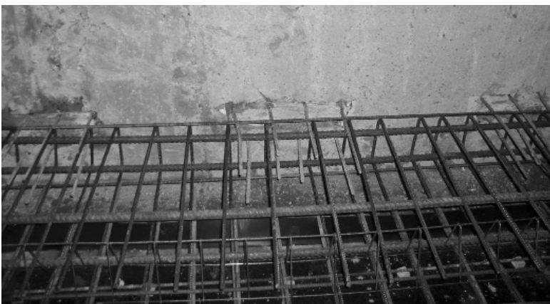
Рис. 4. Узлы соединения перекрытия и ограждения котлована
