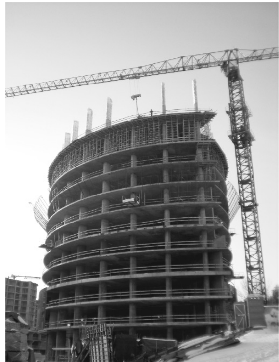
Рис. 4. Mirax Plaza, Киев. Визуализация проекта с башнями А и В (слева), возведение каркаса башни А (справа)
