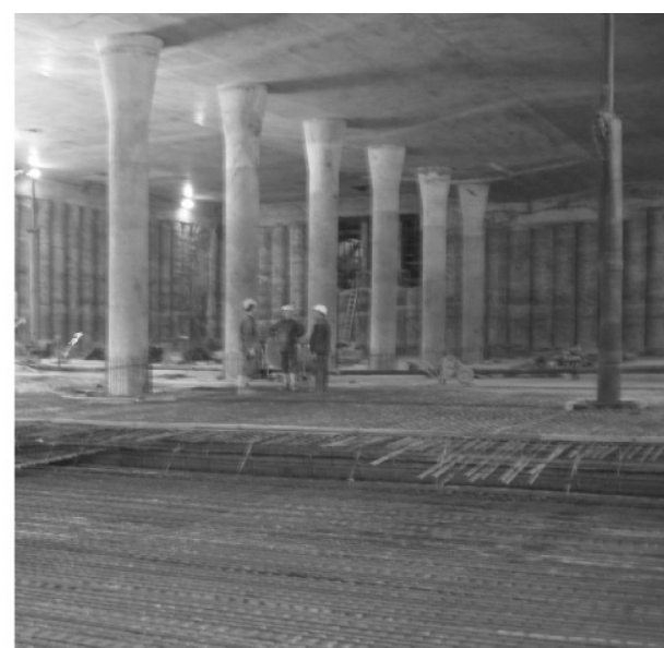
Рис. 3. Строительство подземного паркинга под Гёте Платц во Франкфурте-на-Майне Конструктивные особенности при строительстве методом «сверху вниз»
