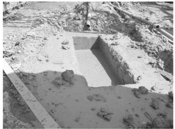
Рис. 3. Устройство комбинированного «бареттно-плитного» фундамента при строительстве высотного комплекса MIRAX PLAZA в Киеве
