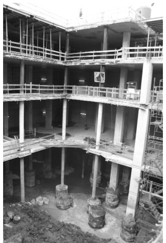
Рис. 5. Устройство временных и постоянных буровых колонн
